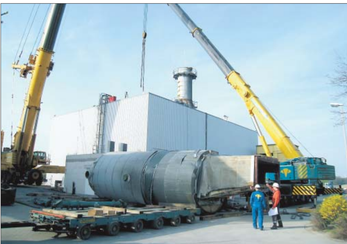
Das Bild verdeutlicht die Dimensionen des Maschinenaustausches an der Gasstation. Bei der Demontage der Gasturbine wird hier gerade der Abgaswärmetauscher (Rekuperator) verladen. Die neue Turbine kommt Ende Mai. ■ Foto: Open Grid Europe
