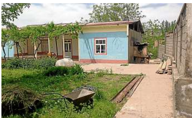
Ein Teil des Altbaus auf dem Gelände ist bereits fertig und steht dem Behindertenverein zur Verfügung.
