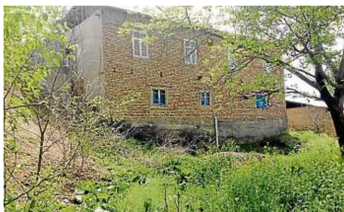
Die Rückseite des Gebäudes, das an den Hang gebaut ist. Fißmer will auch das Untergeschoss ausbauen lassen.
