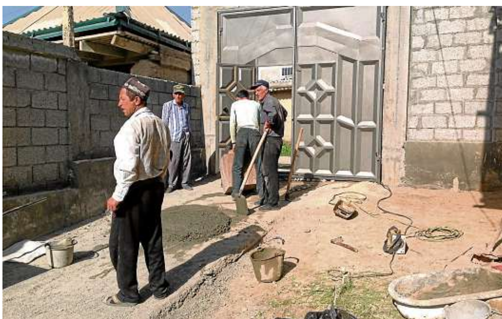
Bei seinem letzten Aufenthalt in Istarawschan hat Dirk Fißmer ein Eingangstor an der Bildungseinrichtung für Behinderte einbauen lassen. Für weitere Investitionen ist er allerdings auf Fördermittel angewiesen, die er bei der Bundesregierung beantragen will.
