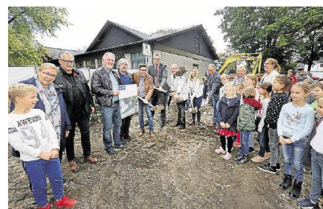
Dezernenten, Kommunalpolitiker und die Klassensprecher der Overberger Grundschule unterstützten Bürgermeister Roland Schäfer und Schulleiterin Melanie Ludwig beim ersten Spatenstich. FOTO: MILK
