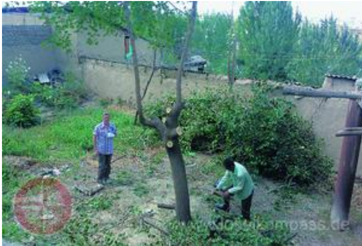
Viel Arbeit hat Dirk Fißmer (l.) in Tadschikistan, um den Bau des Bildungszentrums voranzutreiben. (Foto: privat)
